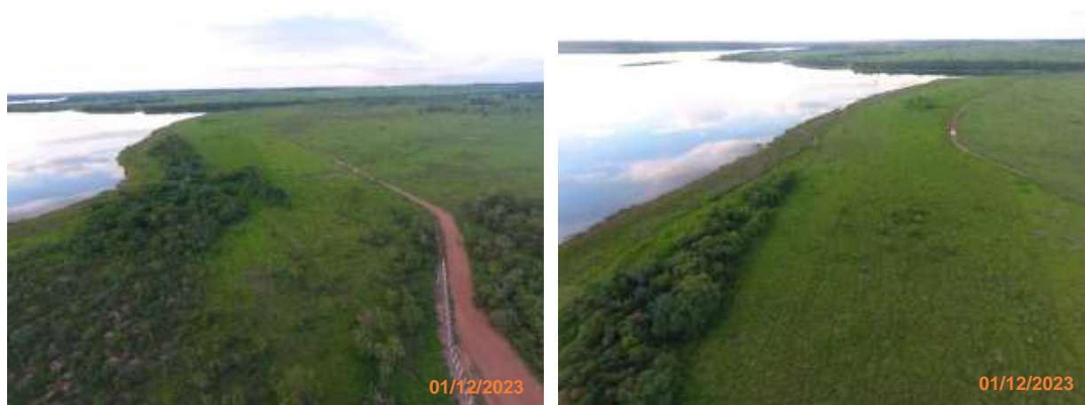
Figura 2. Imagens áreas da APP – Margem esquerda da do reservatório. PCH Verde 4, Ribas do Rio Pardo – MS.
