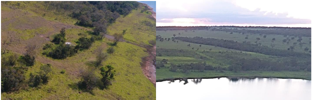
Figura 2 - Imagem aérea da área anteriormente ocupada pela Central de Concreto, Laboratório de Concreto e Solo e Pré-montagem. Esquerda: Junho de 2023; Direita: Dezembro de 2023.
