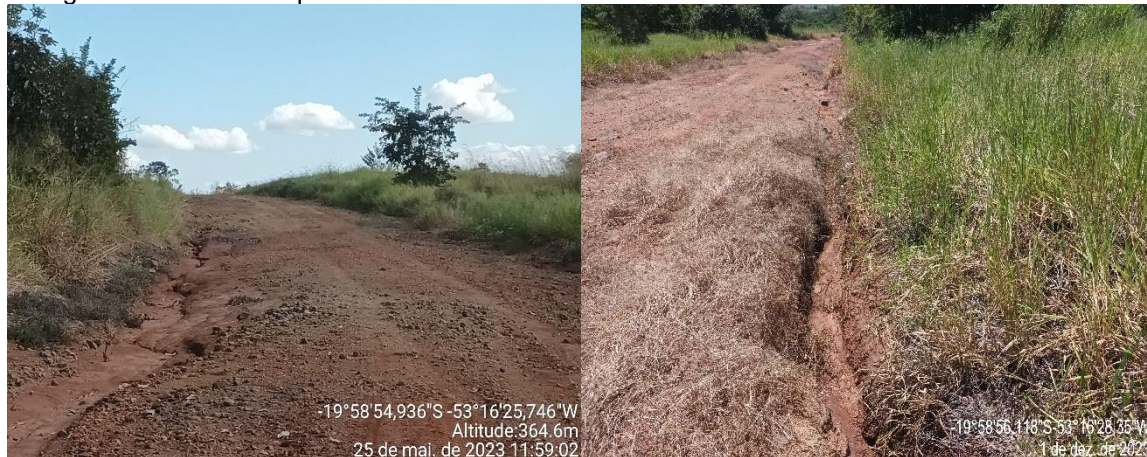
Figura 6. Ponto 4: Erosão em sulcos na lateral da via de acesso, área 2 da PCH Verde 4, no município de Água Clara/MS. Campanhas de 2023.
