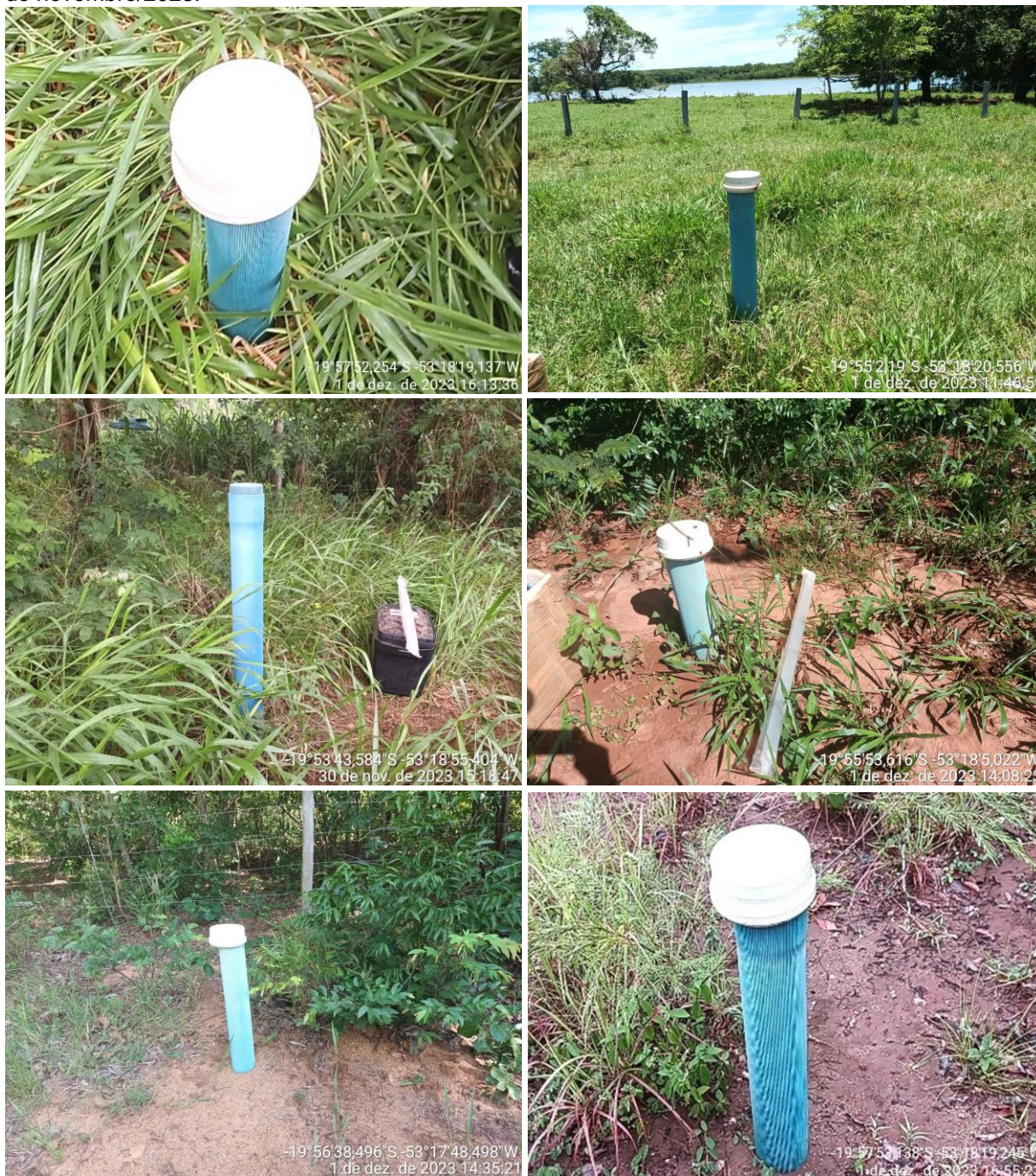
Figura 2 - Poços de monitoramento da PCH Verde 4. Pontos de cima para baixo: P1 a P6. Campanha de novembro/2023.
